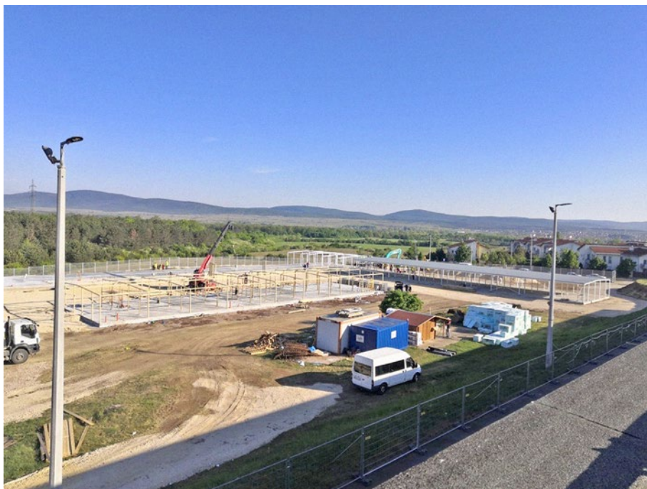
6. ábra: Az épülő II-es objektum 2020. május 11-én
