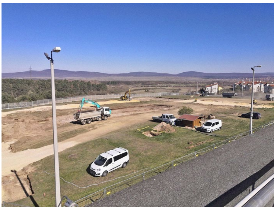
5. ábra: Az épülő II-es objektum 2020. április 7-én
